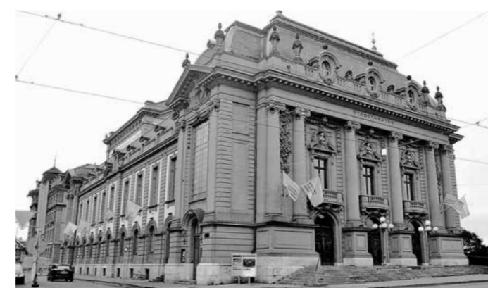
Das 110-jährige Stadttheater hat Renovationsbedarf.
